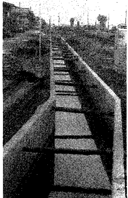
着工進む都市下水路工事(旧中江橋道)
