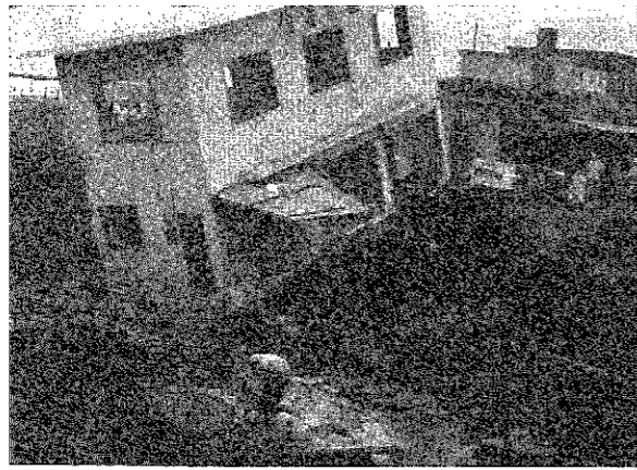
△ 永久建築も傾く 鉄砲水に土台をえぐられ 永久建築も倒壊寸前
