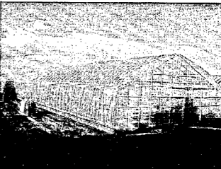
補助を利用してハウスを建設
