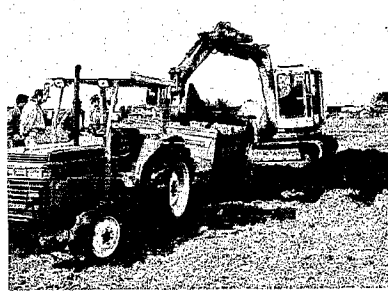
▶バックホーによる積み込み
