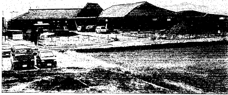
▲着々と工事が進む保健センター・デイサービスセンター。この春オープン予定!!
