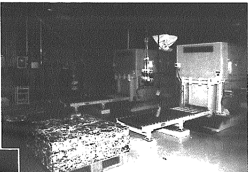
金属圧縮機 奥：スチール用 手前：アルミ用
