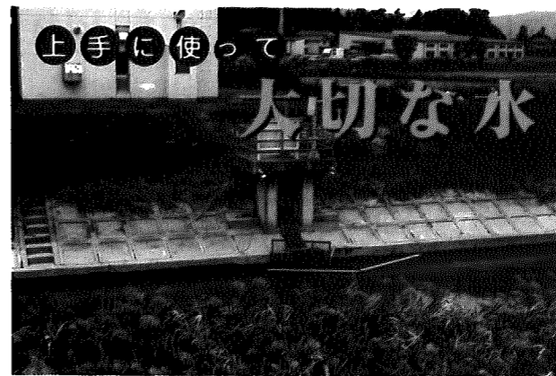
▲西川の岩室村取水口
