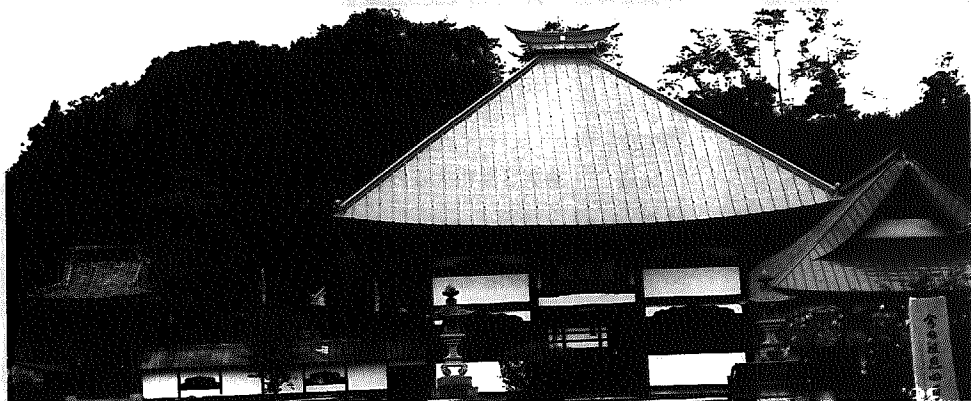
本間久兵衛棟梁家が親、子、孫三代で完成させた常楽寺(中野市)
