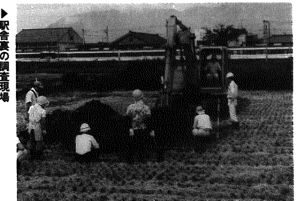
駅舎裏の調査現場
