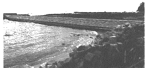
▲護岸外柵工事が完成し、土砂の搬入が始まった間瀬海岸埋立造成事業
