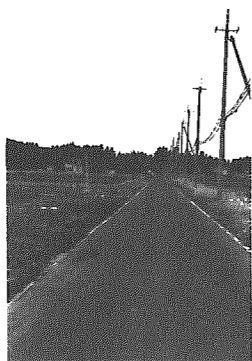
▲整備が進むバイパス工事
