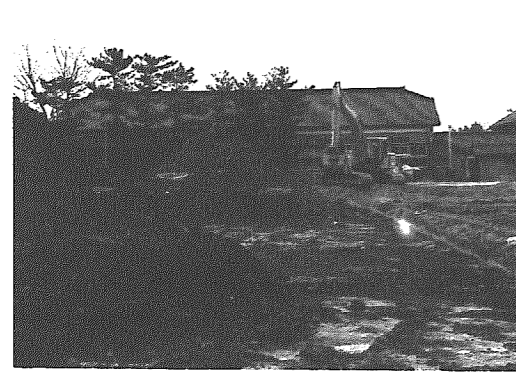
▲平成五年度着工に向けて造成工事が始まった建設用地
