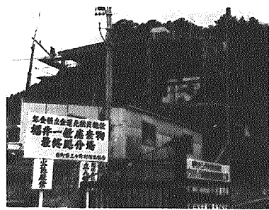
廃プラスチック減容施設(巻町福井埋立地)
