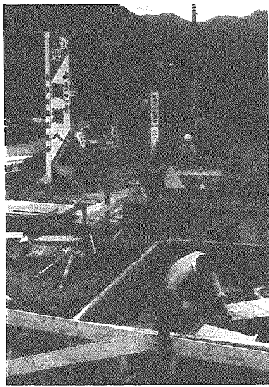
温泉の汲み上げ用ポンプなどの設置準備に忙しい掘削地付近。
