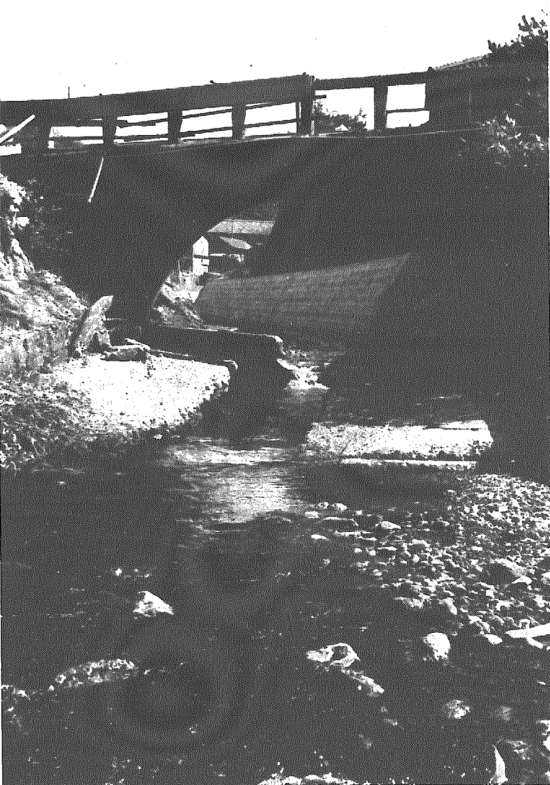
▲白勢橋—現在、県により欄干部分の補修が行われている。支間5.2m、幅員3.7mと小さなアーチ橋だが、人々の生活に欠くことができないものだ。
