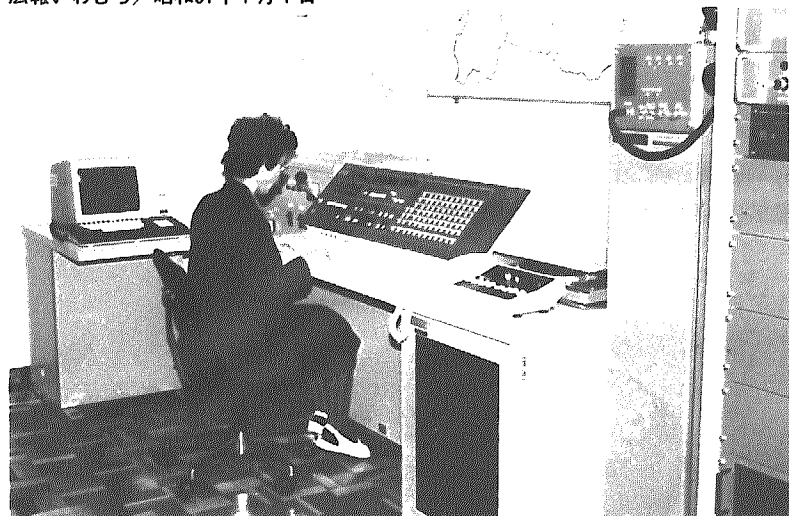
消防防災無線で情報を送る役場内の防災無線室
