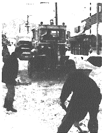
▲連日の雪のため、どこの道路も飽和状態。圧雪も20~15センチと厚くなって凹凸だらけ。圧雪排除後の後仕末はやはり人力が頼りになる。
