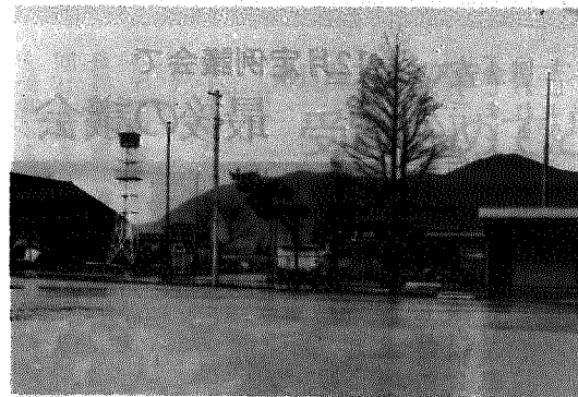
▲新庁舎完成により、すっかり取り壊された旧役場庁舎跡(9~11月)
