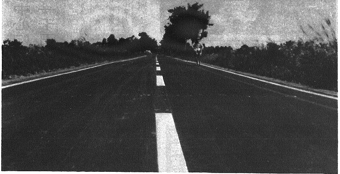
▲ みごとに改良、舗装された夏井～高畑線 (西船越地内)
