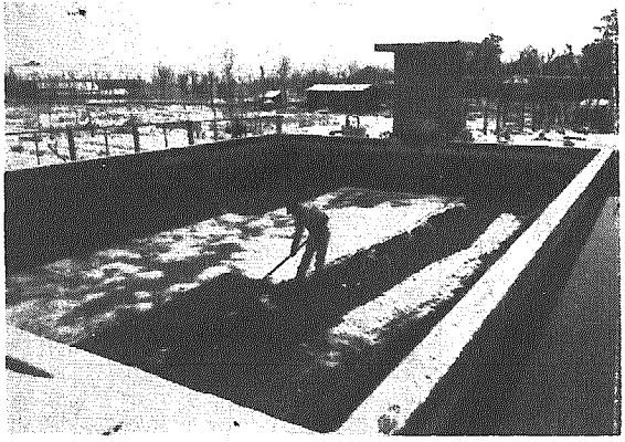
ろ過池の汚れた砂の削取作業
