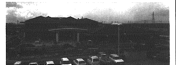
建設中の施設
