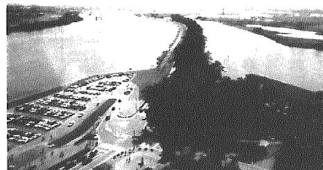
現在も残る堤防。右が揖斐川、左は長良川、手前が川上。最も難工事だったといわれる油島千本松原の堤防(岐阜県海津郡海津町)
