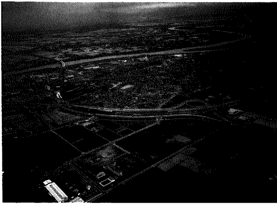
上空から見た西バイパスの様子(平成5年5月撮影)
