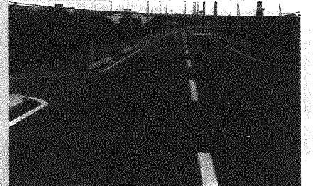
改良の終わった町立鳥原寺地線（立込地内）
