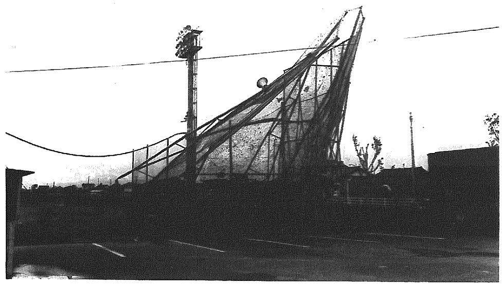
写真右/強風のためにグニャリと曲がってしまった野球場のバックネット。(木場、町営野球場)
