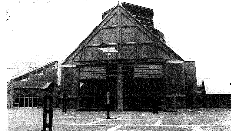
写真上/バザール館側から見たアピール館 中/アピール館の内部。パネルを見ながら3階から1階までスロープを降ります。天井の米俵からは稲穂が下がっています 下/整備中の「降雪体験コーナー」
