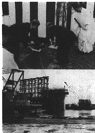
上/安全祈願祭でのくわ入れ 下/工事の進む信濃川橋(仮称)
