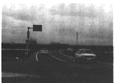
広域農道5号(木場大南橋付近)
