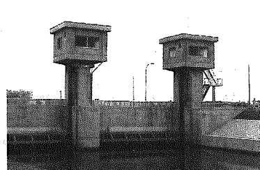
昨年十二月に完成した鷺の木水門
