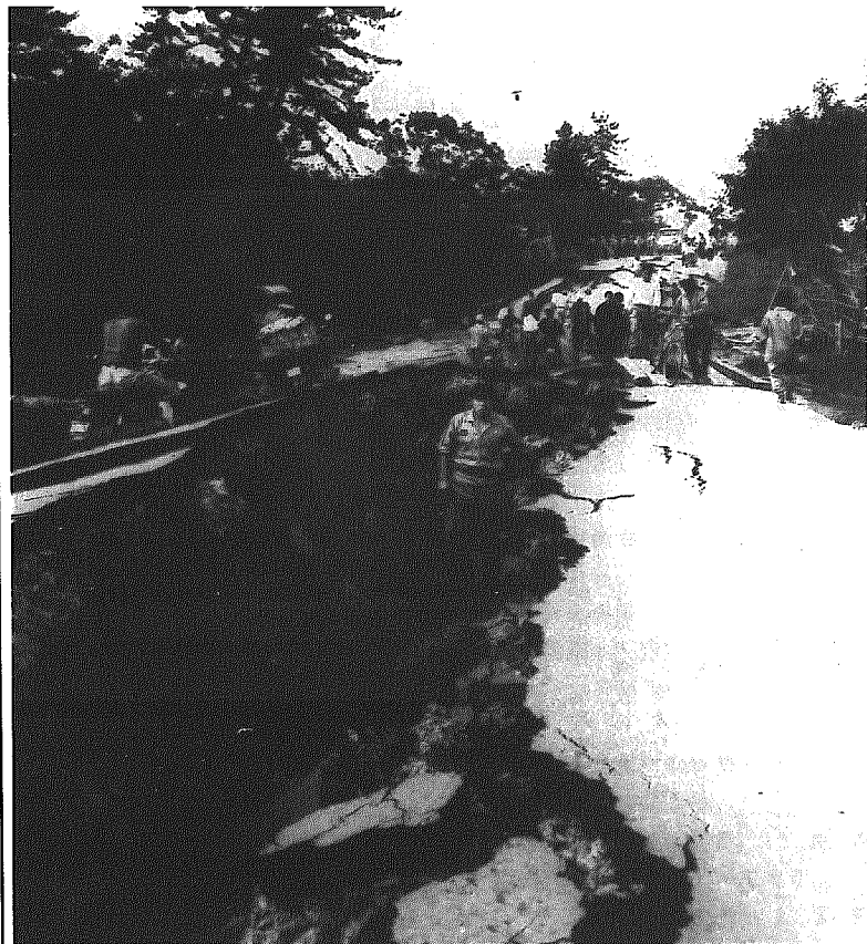
新潟地震により地割れを生じて自動車の通行ができなくなった国道8号(善久地内)。地割れの中に立っているのは筆者。
