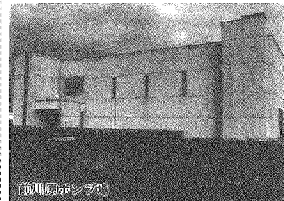
前川原ポンプ場
