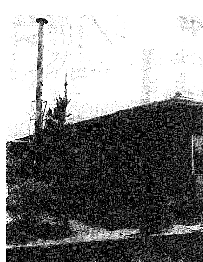
黒埼荘のボイラーと浴室
