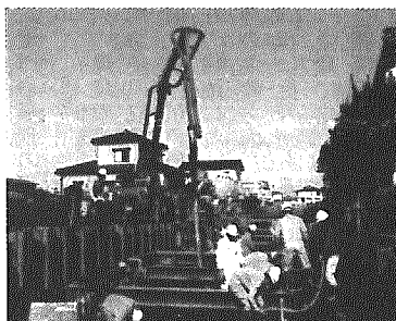
大野都市下水道 大野都市下水道の建設現場。クレーンが管を吊り上げている。作業員が現場を見守っている。
