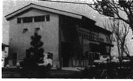
完成したライスセンター
