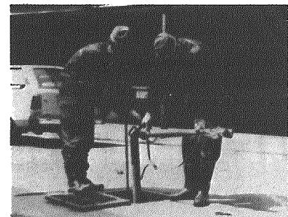
消火栓の移設、新設に375万円
