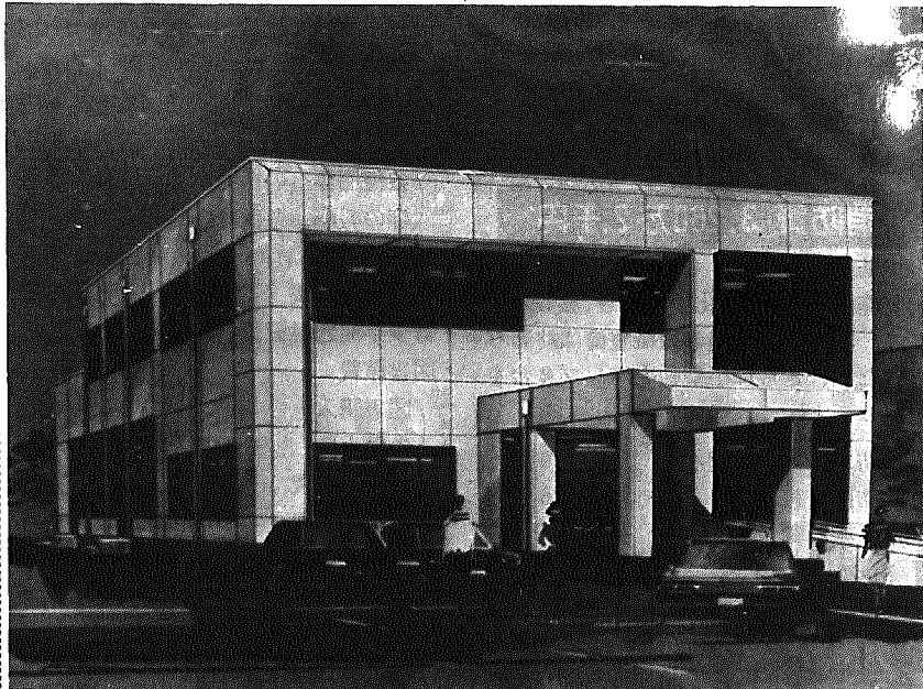
環境改善センター完成予想図。図書館の隣に今年度から3か年事業で建設。ステージ付き多目的ホール、集會室、農事研修室、保健室、調理室などを備える。建物延べ面積1,279㎡ 61年秋に完成予定
