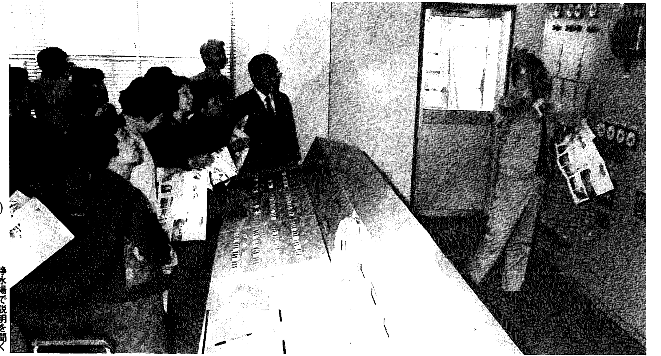
浄水場で説明を聞く
