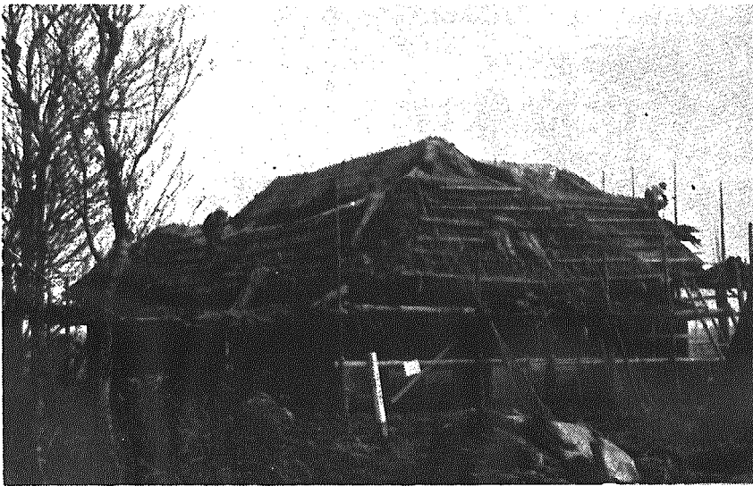
〔文化財史料館〕 武田家の復元工事急ピッチに進む
