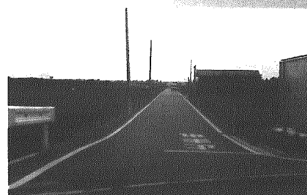
集落道整備 (上曲通地区)
