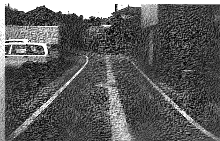
消雪パイプ布設 (上曲通地区)
