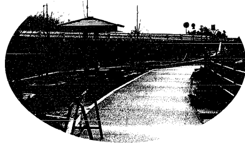
遊歩道の工事が進められて いました。ぜひ一度、足を 運んで見て下さい。
