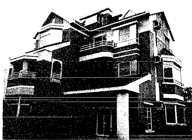
▲ 現地の新築住宅
