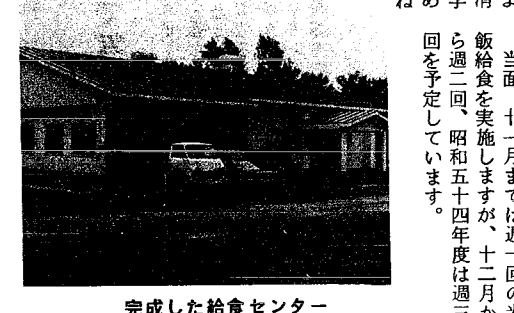
完成した給食センター
