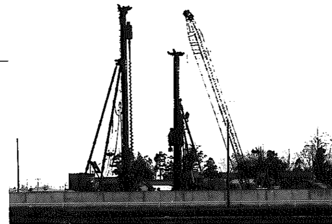
白南中学校校舎棟の建設工事が10月31日から始まりしました。建設工事前には、同校の校章が相馬美香さん(庄瀬中1年)のデザインに決定し、平成15年春の開校を目指して、着々と準備が進んでいます。
