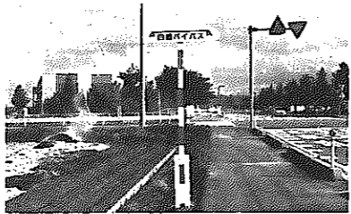
幅杭を設置、用地測量へに入った7工区
