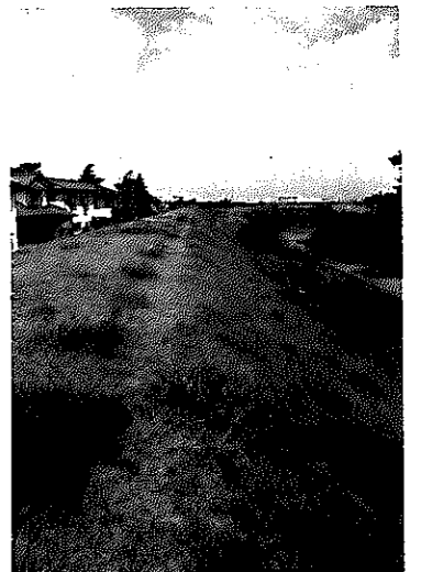
▲桜町付近の完成堤防
