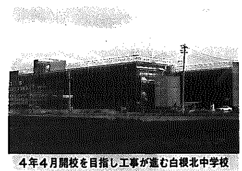
4年4月開校を目指し工事が進む白根北中学校
