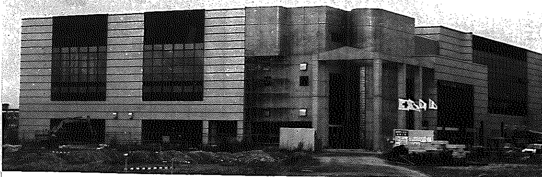
市民の期待と夢をのせたカルチャーセンターは、完成間近
