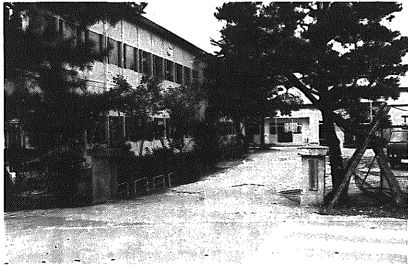
▲完成した「ピッカリ戸石っ子校舎」
