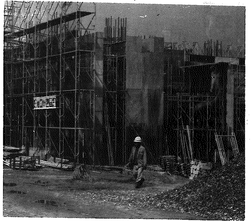
▲平成2年3月の完成を目指し工事は急ピッチ（カルチャーセンター）
