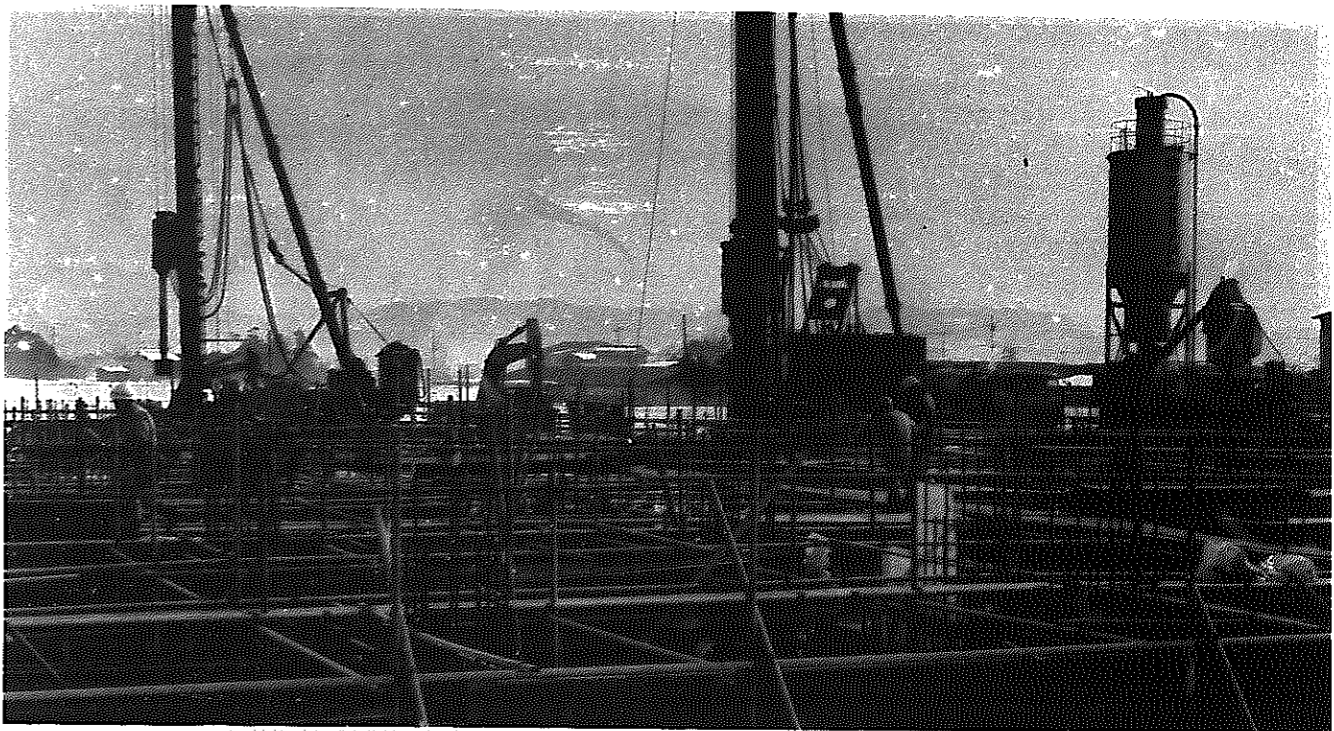
昭和65年春の完成を目指して、工事は急ピッチで進められています。
