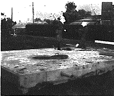
防火水槽の設置工事(下八枚地内)
