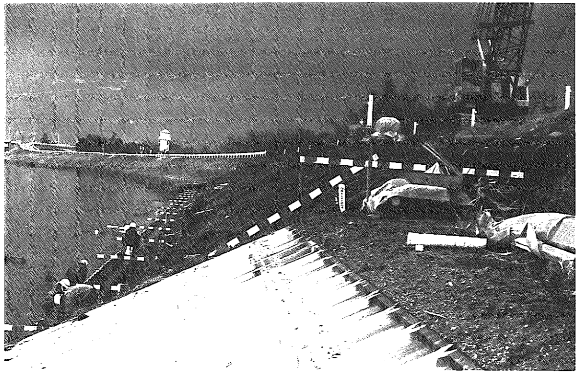
中ノ口川の堤防改修工事は、中小河川改修事業と河川災害復旧事業を並行して進められています
